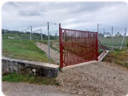
Réalisation et pose d'une clôture et d'un portail au stade.
