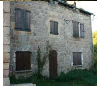
Le presbytère avant travaux
