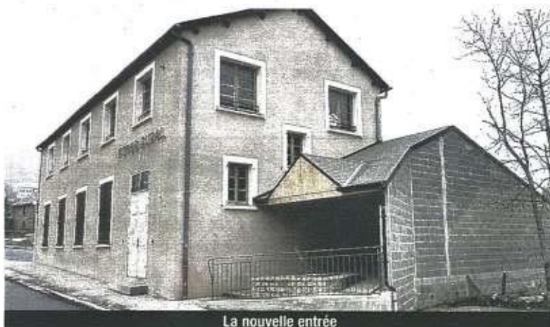
La nouvelle entrée
